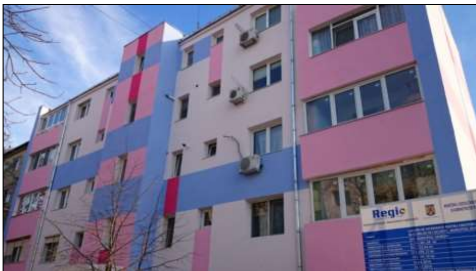
foto 24 finalizarea lucrărilor de intervenții pentru creșterea performanței energetice a blocurilor de locuințe, mun. Giurgiu, ansamblul 2
