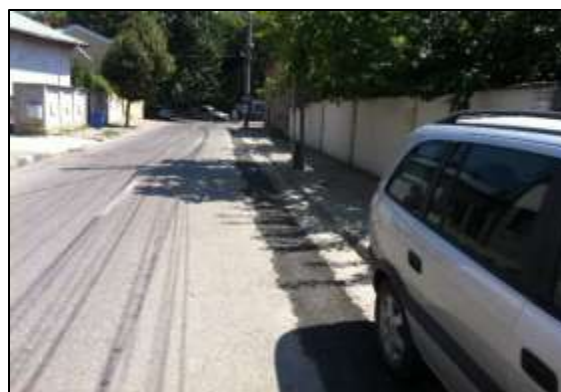
foto 34 Extindere Strada Plevnei
