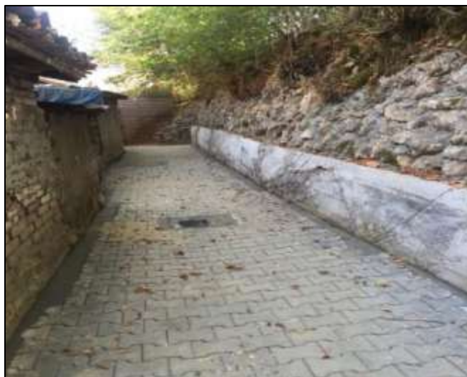
foto 99 - Reabilitare zid de sprijin și realizare alee pietonală adiacent Aleea Fabricii de Zahăr
