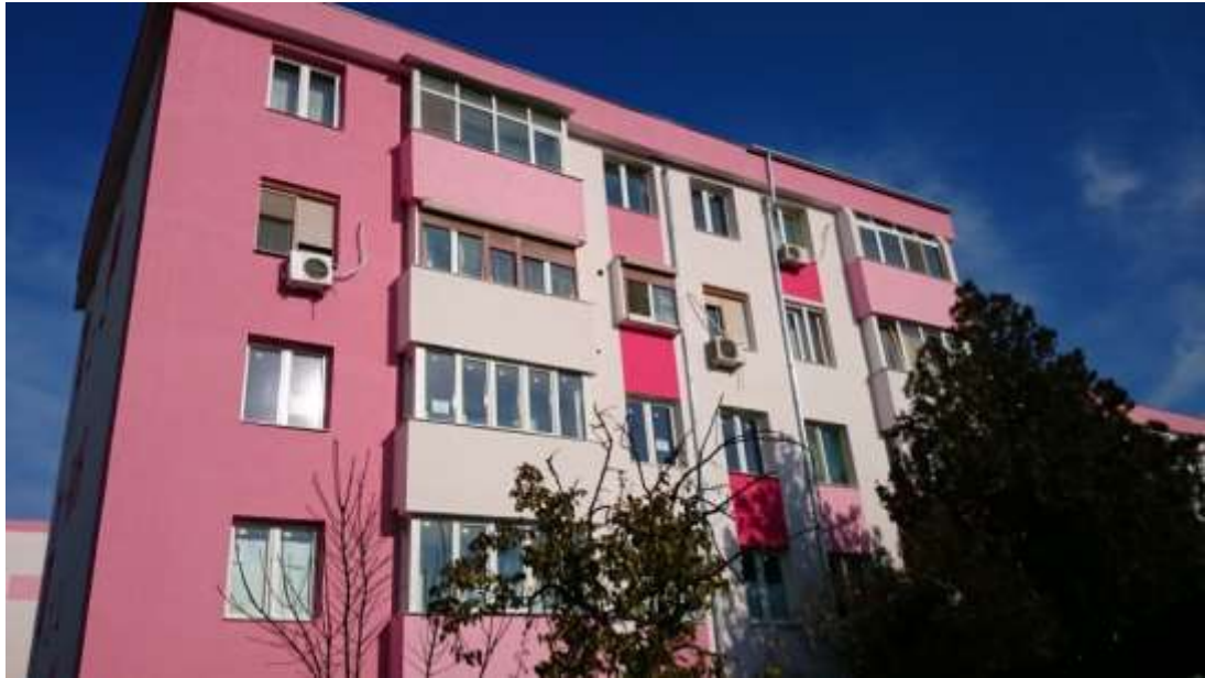
foto 23 - finalizarea lucrărilor de investiții pentru creșterea performanței energetice a blocurilor de locuințe, mun. Giurgiu, Ansamblul 1
