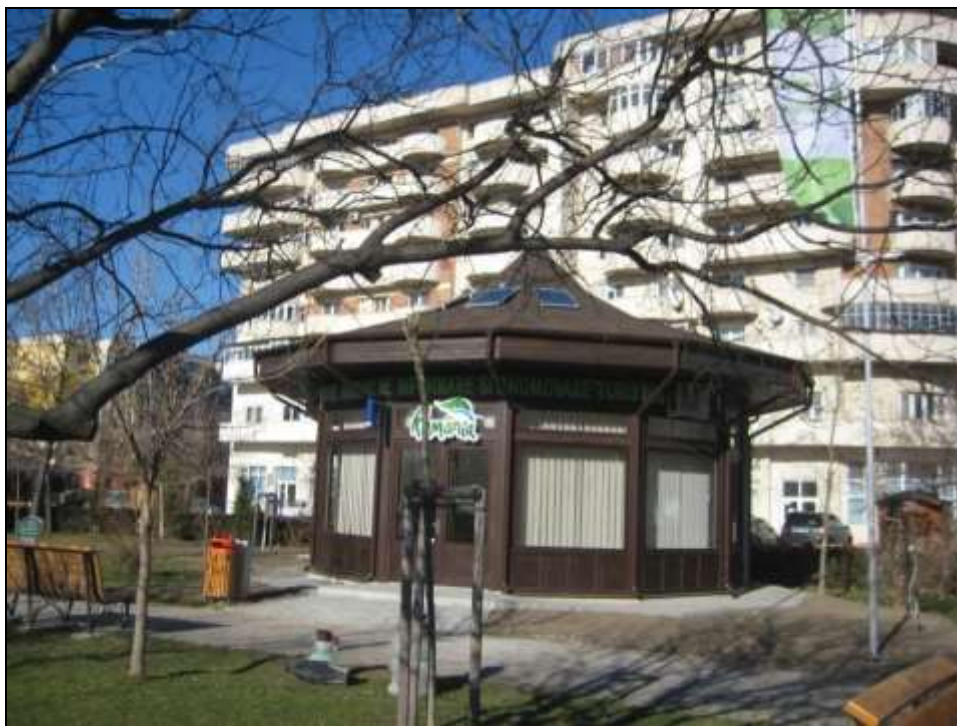
foto 25 Finalizarea construcției investiției - Centru Național de informare și promovare turistică – Giurgiu
