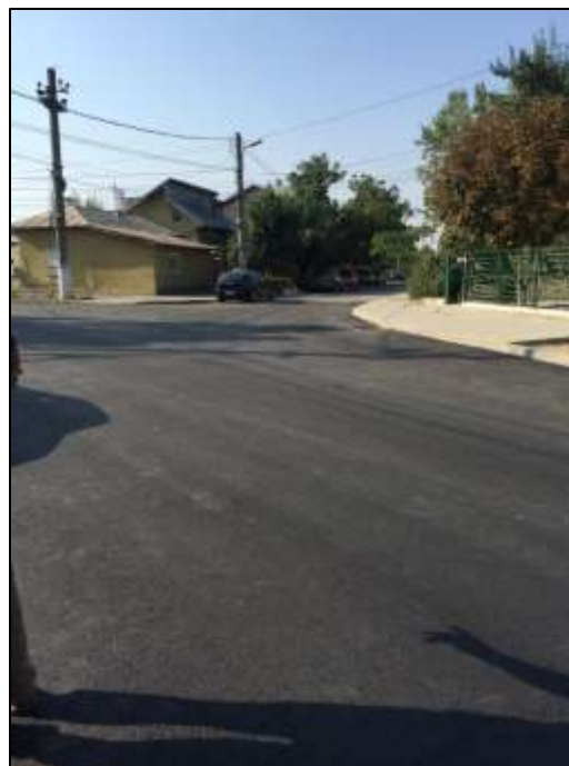
foto 96 - Reabilitare asfaltică Strada.23 August
