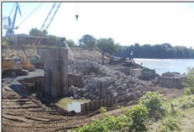
foto 4 -lucrări de demolare a construcțiilor existente - octombrie 2016
