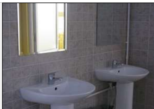
foto 9 - Liceul Ion Barbu - Reparații grupuri sanitare
