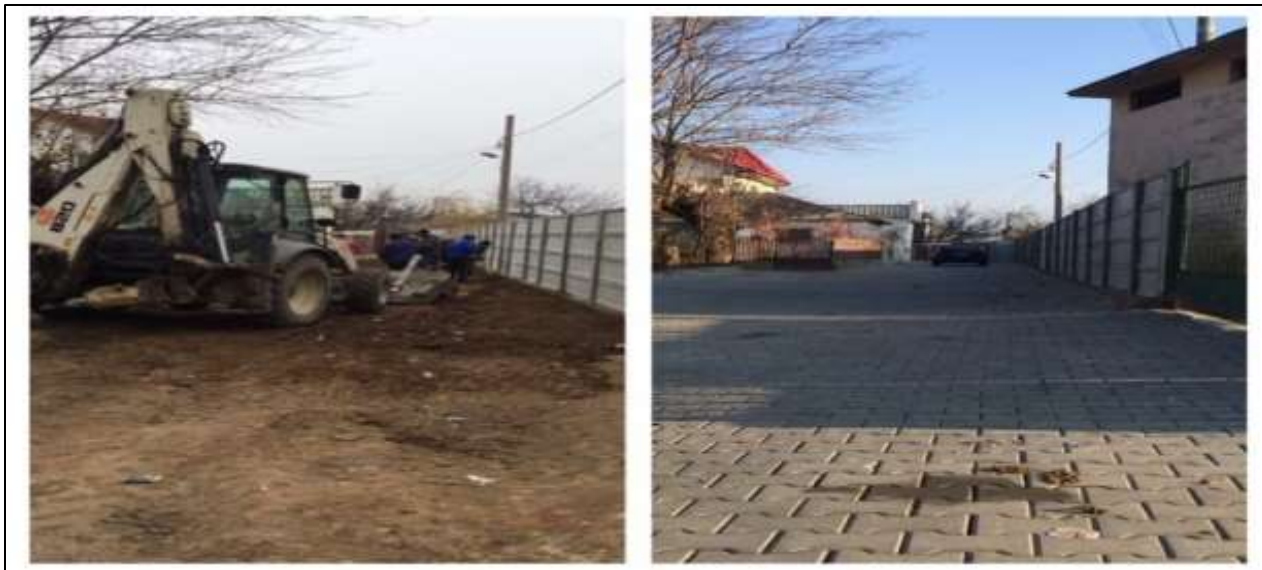
foto 97 - Reabilitare stradă de pământ cu dale behaton Fundătura.23 August - ÎNAINTE ȘI DUPĂ
